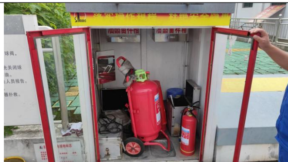
荆门东站消防器材箱
