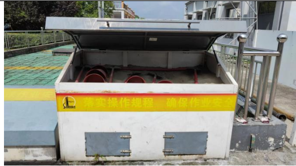
荆门东站消防沙箱
