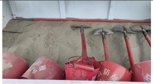
荆门西站消防沙箱
