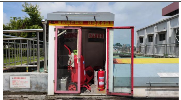
荆门西站消防器材箱
