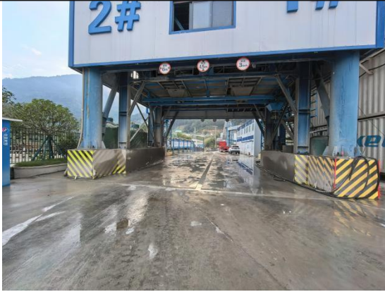
洗车废水导流槽
