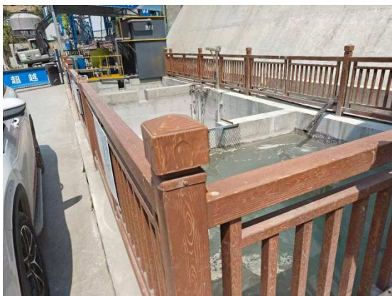
废水处理车间
