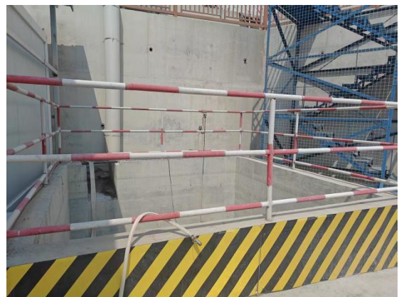
初期雨水收集池
