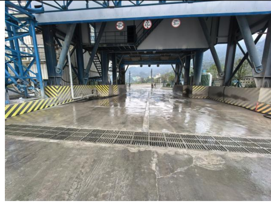
洗车废水导流槽
